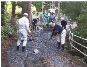
農道の軽微な補修
