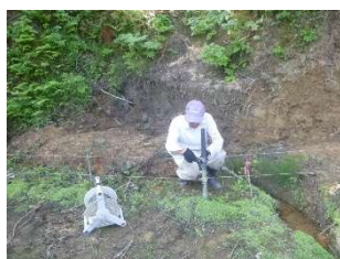
鳥獣害防護柵の補修
