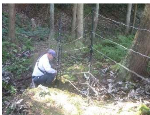
鳥獣害防護柵の補修
