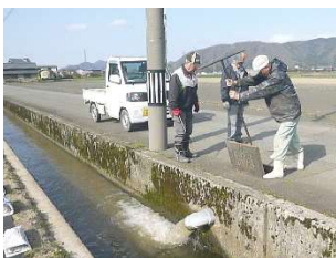
パイプ内清掃
